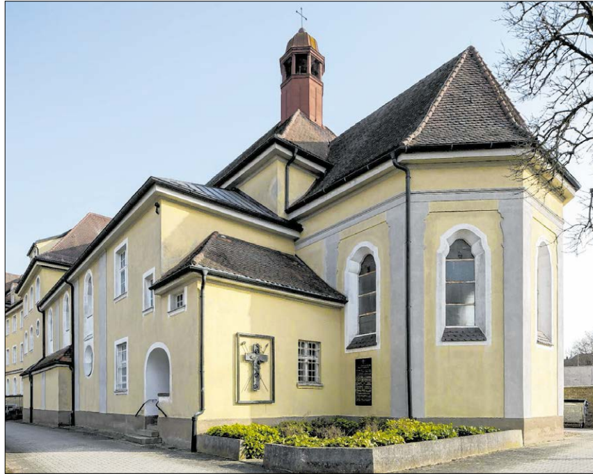
▲ Blick auf die Kirche und das sich anschließende Gebäude des früheren Klosters beziehungsweise des Studienseminars. Foto: Stadt Regensburg. Bilddokumentation
